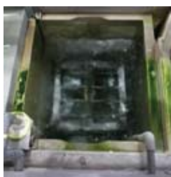
製品洗浄槽 (左側にコラムを設置)
